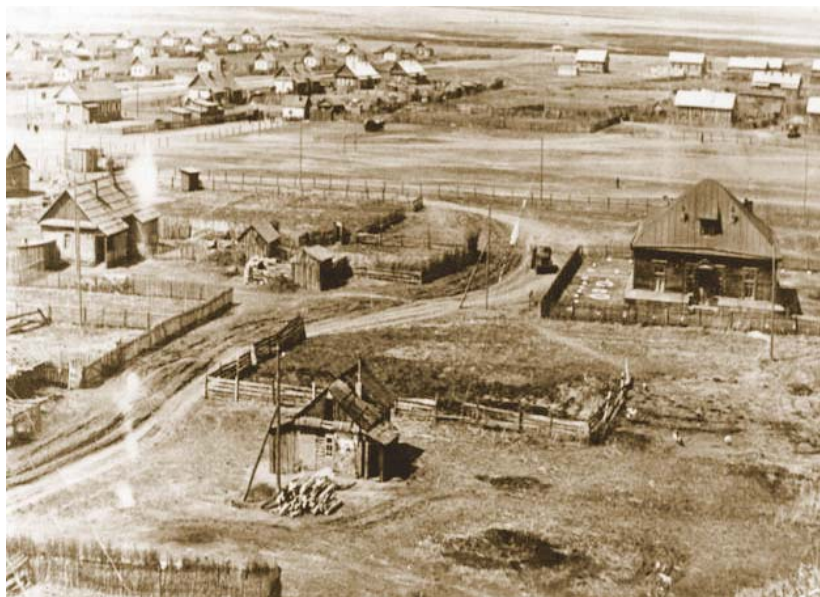
Сосновка, 1961 год. На переднем плане баня постройки 1933 года. Справа – первая больница постройки 1956 года. В центре – стадион. Слева – одиночное здание столовой, на дальнем плане микрорайон «Тамбовка», напротив него въездная арка в населённый пункт
